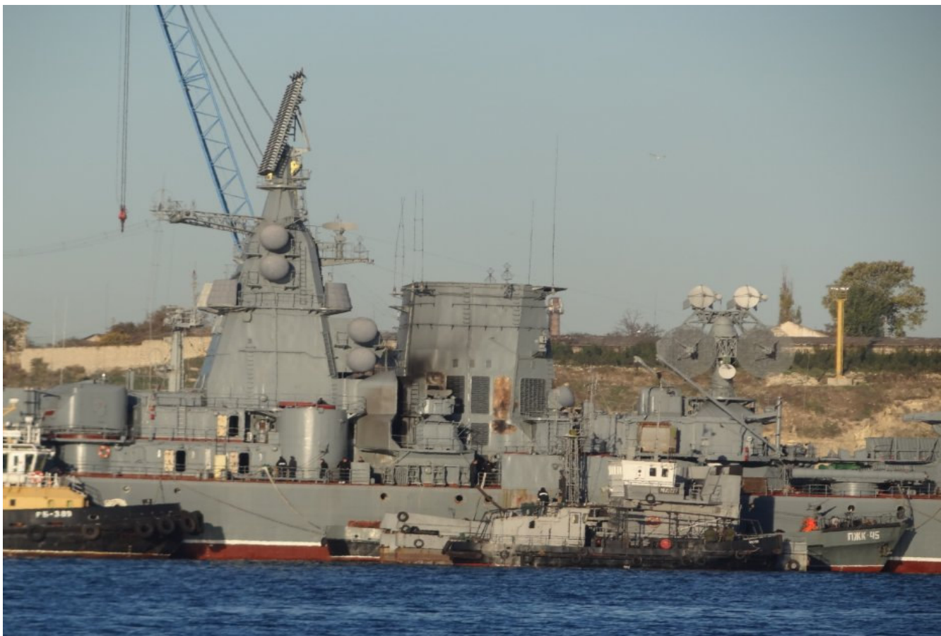
БПК "Керчь" после пожара
